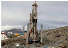
山地打孔施工 Mountain drilling
