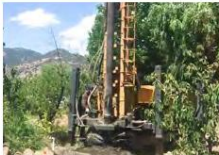
山地打孔施工 Mountain drilling
