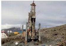
山地打孔施工 Mountain drilling
