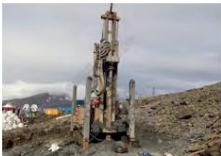
山地打孔施工 Mountain drilling
