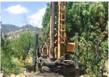
山地打孔施工 Mountain drilling
